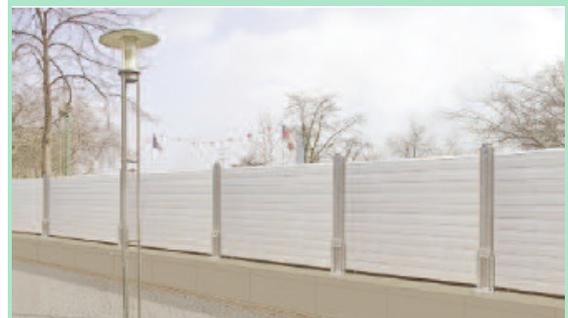
Stützpfeiler für den mobilen Wall erreichen bis zu 2,20 m. Foto - Simulation von IBS
