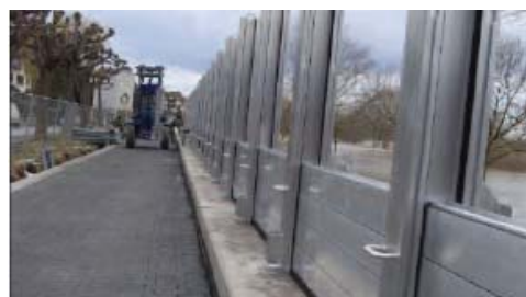
Mobil översvämningsbarriär undviker konflikter med befintlig miljö. Foto: Flood Protection Centre Cologne, Reinhard Vogt
