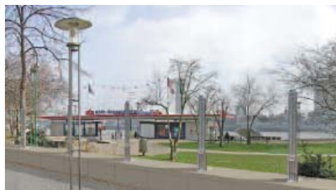
Pelare för en mobil översvämningsbarriär i den gamla delen av staden, Cologne, Tyskland. Foto: Simulering av IBS
