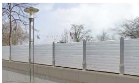
Pelare för den mobila barriären kan bli upp till 2,2 meter. Foto – simulering av IBS
