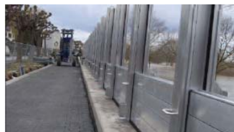
Mobile barrierer undgår konflikter med det eksisterende miljø. Foto: Flood Protection Centre Cologne, Reinhard Vogt
